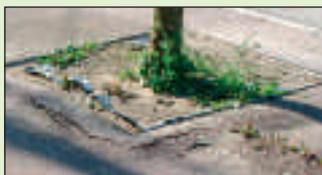
Le soulèvement des trottoirs et des grilles métalliques entourant les troncs devenant un danger pour les piétons (photo 1), ceci associé aux risques d'endommagement des réseaux de gaz et d'eau en sous-sol, décision a été prise de dessoucher les arbres.
